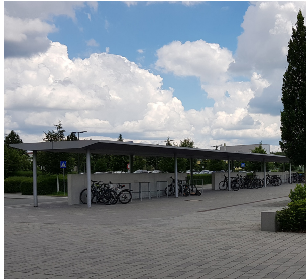
+ überdachte Fahrradabstellanlagen am Gymnasium
