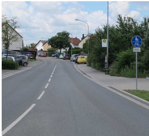
- abrupt endender Radweg ohne Weiterführung auf Straße
